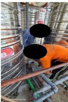
การสูบตะกอนระบบบำบัดน้ำเสีย
